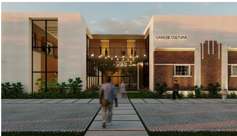
Fonte: Troyano Arquitetura, 2022.
