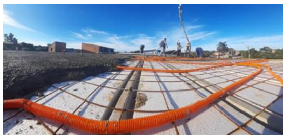
Figura 5 Laje em Eps “in loco”
