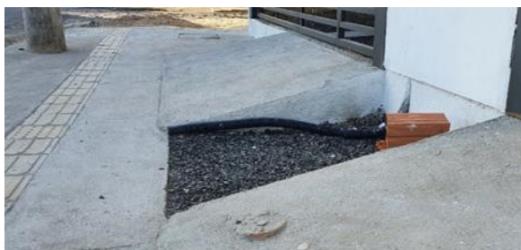
Figura 8 Rampa de acesso a garagem
