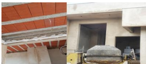
Figura 6 Residência : laje em Telas Cerâmica
