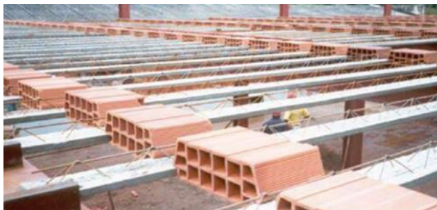
Figura 1 Montagem Simples de lajota cerâmica – Tavelas
